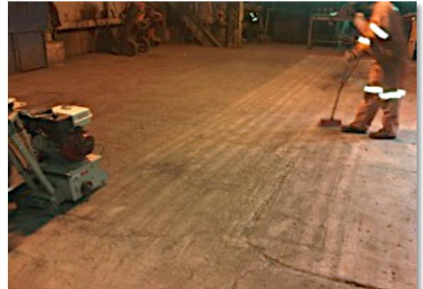
Una vez hecha la reparación, se escarifica todo el piso en sentido cruzado, preparando la superficie para la aplicación del **CHEMCLAD SC** como revestimiento final.
