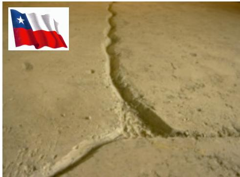
El piso del taller presentaba un avanzado deterioro junto a numerosas grietas y juntas estructurales dañadas.
