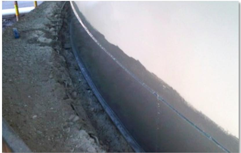
*El deterioro de la base de hormigón corriente del estanque acumulador de Oxígeno Líquido fue producto de los constantes derrames en su operación. Luego de hacer una limpieza del anillo alrededor del estanque se refuerza con **ENECRETE DuraQuartz**. Para el sellado final se aplicó **CHEMCLAD SC** en 2 dos capas.*
