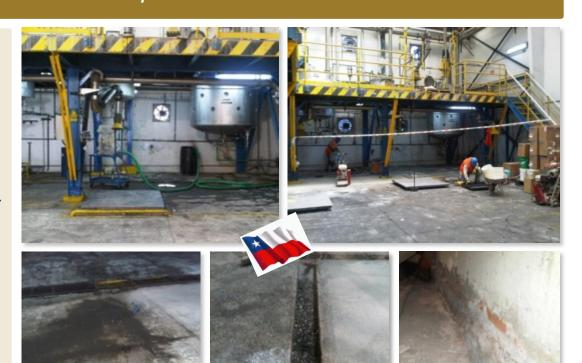
Como preparación superficial se realizó un escarificado y luego se procedió a emparejar y nivelar la superficie mediante la aplicación **ENECRETE DuraFill** mezclado con cuarzo en un espesor medio de 5mm. Como terminación se aplicaron 2 capas de **CHEMCLAD XC** para una máxima protección contra ataque químico.
