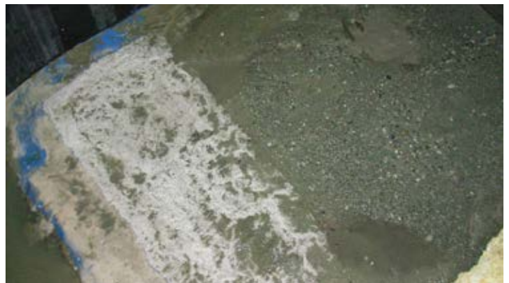
Estado después de 8 años de realizada la reparación.
