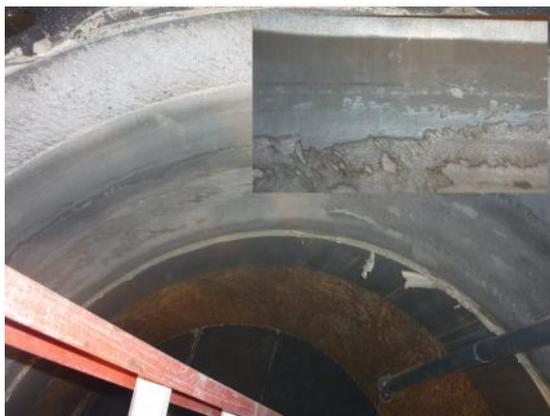
La superficie de la carcasa de la turbina presenta señales de abrasión importante. Se procedió con la limpieza y granallado de la base con el fin de dar mayor anclaje y dejar en máxima evidencia zonas con exceso de desgaste.
