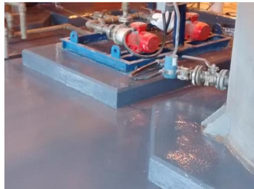
En esta sala de procesos de una Empresa de Generación Eléctrica, el ácido existente en pisos y receptáculos terminó por deteriorar todo, incluyendo un antiguo revestimiento existente.
