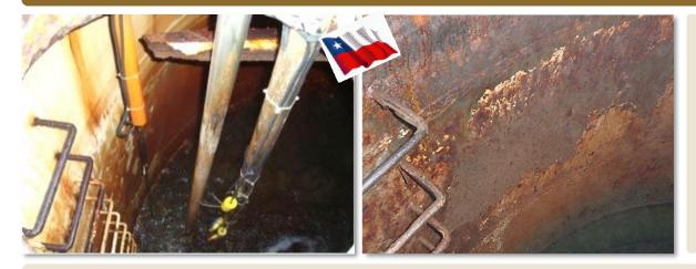
Estanque metálico presentando gran cantidad corrosión interior y exterior, debido a dificultades para realizar las mantenciones necesarias.
