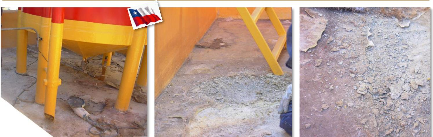
Pretil sometido a continuos derrames de ácido sulfúrico presenta profundo deterioro de la estructura. Se realiza un retiro completo del revestimiento existente y de hormigón contaminado. Para la recuperación se utiliza **ENECRETE DuraFill** mezclado con cuarzo el cual se aplica en piso en un espesor medio de 8 mm. Para proteger la totalidad del área se aplican 2 manos de **CHEMCLAD XC**, revestimiento polimérico resistente a cualquier concentración de ácido sulfúrico.
