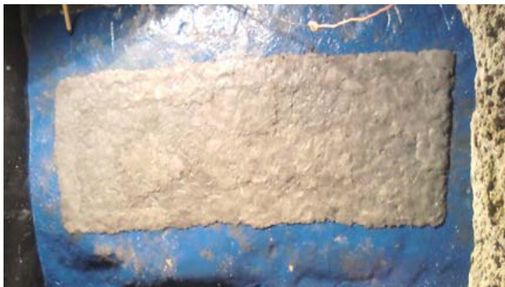
Socavón recubierto con METALCLAD CeramAlloy CBX
