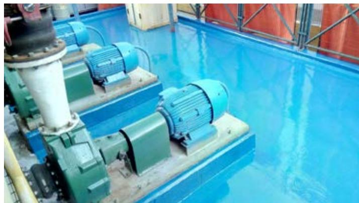
La conclusión de las pruebas fue que la protección de pisos con CHEMCLAD XC resiste perfectamente la exposición a los ácidos concentrados utilizados en la Planta. Tras estos resultados, se procedió a su aplicación en pisos, pretilas de contención, bases de bombas y barandas de escaleras, ya que los sistemas CHEMCLAD pueden ser usados en todo tipo de maquinarias, equipos y estructuras.
