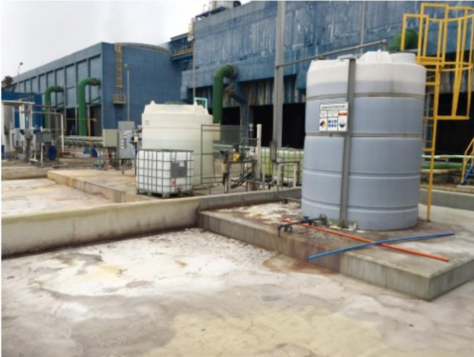
Áreas de contención secundaria de estanques de Ácido Sulfúrico al 98% y de Hipoclorito de Sodio al 10% presentan grave deterioro de los hormigones debido al ataque químico producido por los frecuentes derrames y filtraciones de los sistemas anexos.
