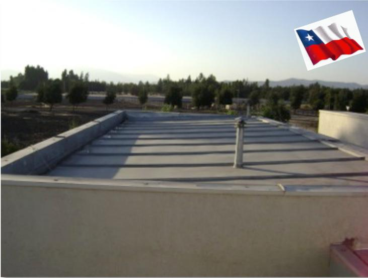
En la techumbre de 125 m<sup>2</sup> de una casa particular en condominio, presentaba serios problemas de filtración de aguas lluvias por la mala instalación de su cobertura de planchas de material galvanizado.
