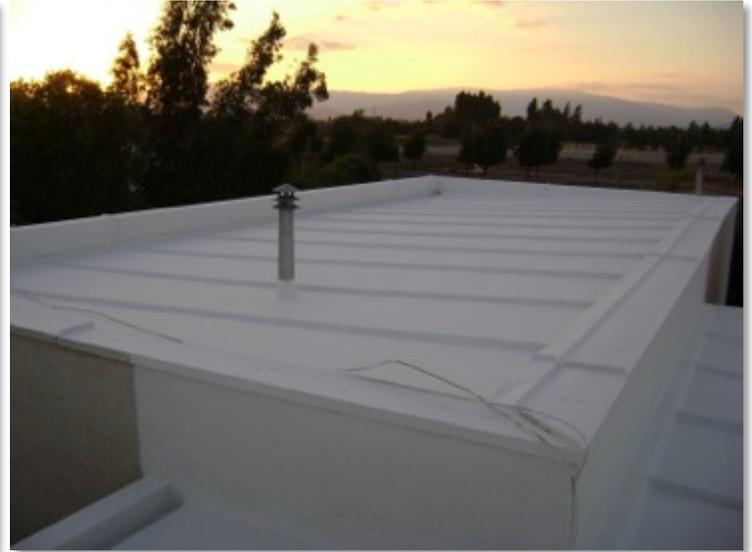
La superficie fue preparada con un hidrolavado. Se sellaron las uniones abiertas y se aplicaron 2 manos de **ENESEAL HR**. El cliente informó que notó una disminución en la temperatura interior. Esto debido a la propiedad de **ENESEAL HR** de refractar la radiación solar.
