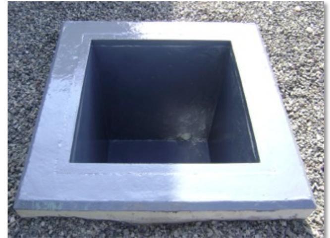
Se observa el pretil de descarga de ácido sulfúrico y cámara de inspección, sujetas a constantes derrames y flujos de ácido, causando un gran deterioro del hormigón. La solución definitiva dada por **ENECON** se logró con **CHEMCLAD XC** para ataque químico severo.
