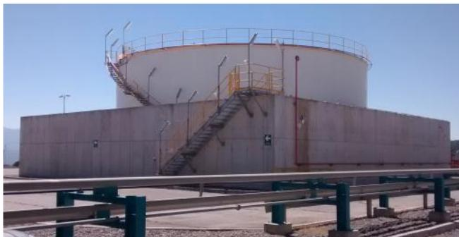
Importante cliente, por breve parada de planta, necesitaba una rápida aplicación de revestimiento en su TK 2000 de Diesel. La solución propuesta por **ENECON**: puente de adherencia con **ENECLAD SuperBond** y terminación final **ENECLAD FPS**, de alta resistencia a combustibles. El revestimiento fue aplicado en solamente 3 días.
