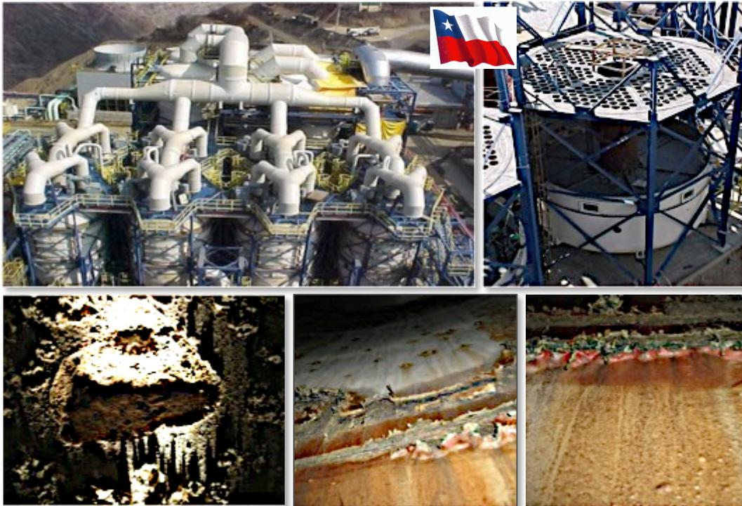
Problema de Corrosión extrema de las paredes de acero en el interior de precipitadores después de 20 años de servicio, sin posibilidad de hacer mantenencias desde que fueron instalados. El ambiente de operación dentro de estos precipitadores es moderadamente ácido.
