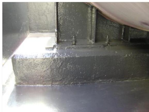
Solución propuesta: se aplicó **ENECRETE DuraFill** para recuperar los muros y el piso del pretil y, finalmente, **CHEMCLAD XC** para dar protección química, dejando operativo en un 100% y prolongando la vida útil del pretil.
