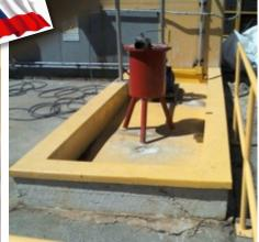
Pretil sometido a continuos derrames de ácido sulfúrico presenta profundo deterioro de la estructura. Se realiza un retiro completo del revestimiento existente y de hormigón contaminado. Para la recuperación se utiliza **ENECRETE DuraFill** mezclado con cuarzo el cual se aplica en piso en un espesor medio de 8 mm. Para proteger la totalidad del área se aplican 2 manos de **CHEMCLAD XC**, revestimiento polimérico resistente a cualquier concentración de ácido sulfúrico.
