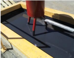
Adicionalmente **CHEMCLAD XC** es utilizado para proteger receptáculo de descarga fabricado en acero al carbono.
