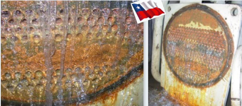
Intercambiador de calor con 8 años de uso presentando corrosión y erosión acentuadas, comprometiendo el buen funcionamiento del sistema de enfriamiento.
