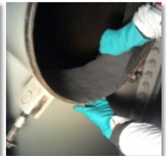
La solución ENECON ha entregado una completa recuperación de la superficie metálica y protección contra la corrosión y ataques químicos moderados. Esta solución permitirá que el condensador pueda mantenerse en proceso sin interrupciones frecuentes. Como consecuencia el cliente reducirá sus gastos asociados con la mantención y parada de equipos críticos.
