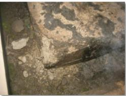
Base de bomba y zona aledaña de hormigón con serios deterioros debidos a bajas temperaturas y a los continuos ciclos de hielo deshielo. La solución propuesta por ENECON consistió en retirar todo el material suelto, para luego mediante la utilización de ENECRETE DuraQuartz recuperar y devolver las dimensiones originales de la base.
