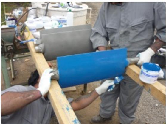
*Se aplicó **METALCLAD® CeramAlloy CP+AC** con el fin de recuperar espesores y formas en el equipo. Finalmente se aplicó **METALCLAD® CeramAlloy CL+AC** como terminación final contra la abrasión.*
