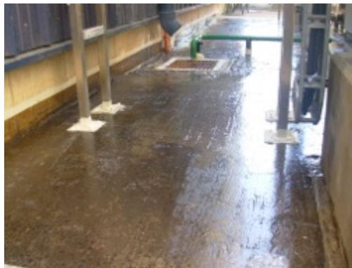
El radier en el área de desalinización de agua necesitaba un recubrimiento capaz de resistir agua salada en gran concentración, tránsito pesado y con la propiedad de ser aplicado con los equipos en funcionamiento. La solución **ENECON** aprobada por el cliente, consistió en la aplicación de **ENECLAD CFS** como imprimante, sello y reforzamiento del concreto.
