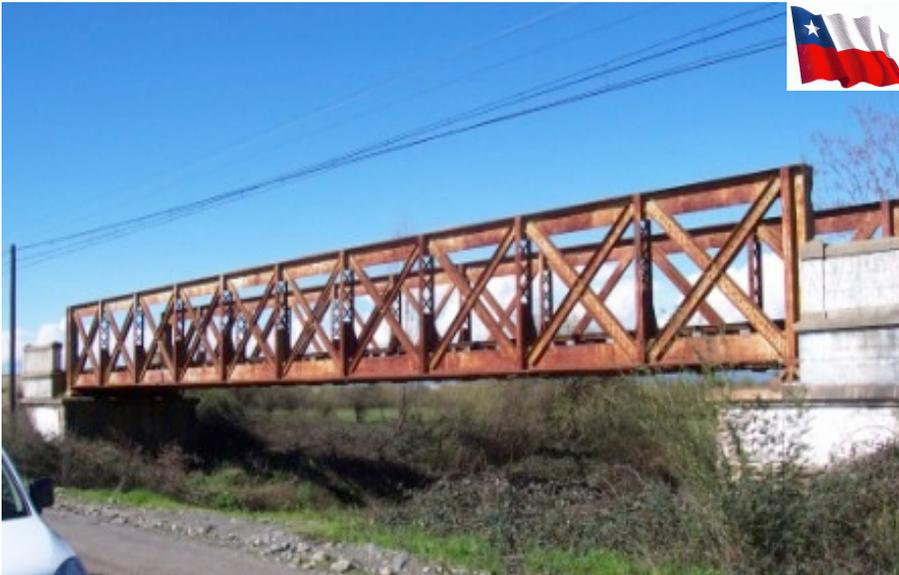
*Revestido con **ENESEAL CR**, revestimiento elastomérico flexible, en base a agua, resistente a la corrosión y a los rayos UV. Revestimiento incluye inhibidores de la corrosión y agregados inorgánicos resistentes a la erosión.*
