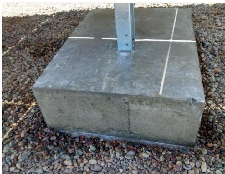
Para evitar el daño de los hormigones se aplicó **ENESEAL MP** ya que provee una barrera climática, evitando que el agua ingrese al sustrato debido a sus características hidrorrepelentes. De esta manera, se previene el daño causado por el agua al expandirse por congelación. Extremadamente fácil de aplicar, **ENESEAL MP** entrega una solución extraordinaria para contar con infraestructura en buen estado por muchos años.
