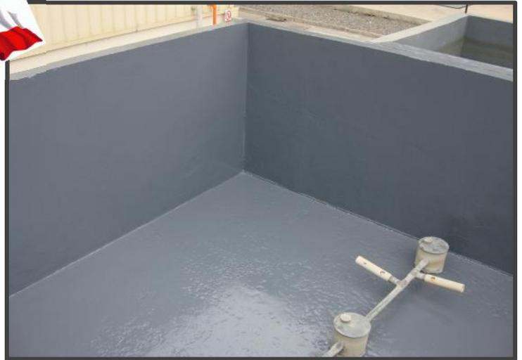
*Escarificado de la superficie y recuperación de paredes y piso con **DuraFill**. Luego, aplicación del imprimante **ENECLAD CFS** y 2 capas de **CHEMCLAD XC** para protección ante ataque químico severo. La solución **ENECON** permite, además, protección al medio ambiente ante posibles filtraciones.*
